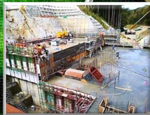
②ダムサイトを間近で見学
